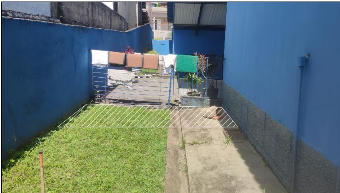
Figura 9 - Local onde será feito um piso de concreto para acertar e nivelar a entrada para o corredor
