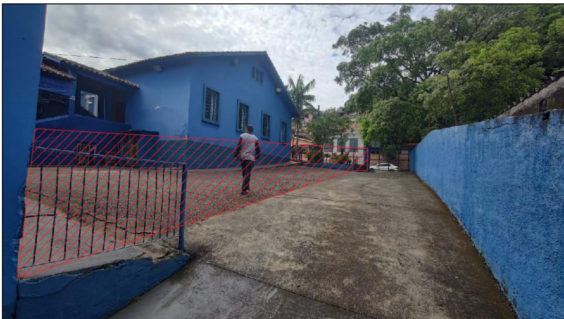
Figura 3 - Local de construção de muro de divisa (em vermelho)
