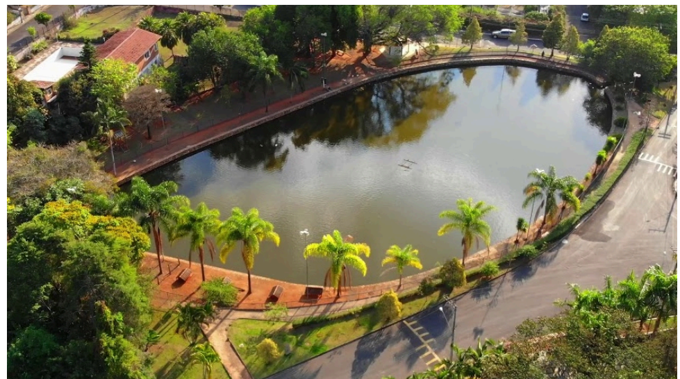
Lago dos Patos em obra
