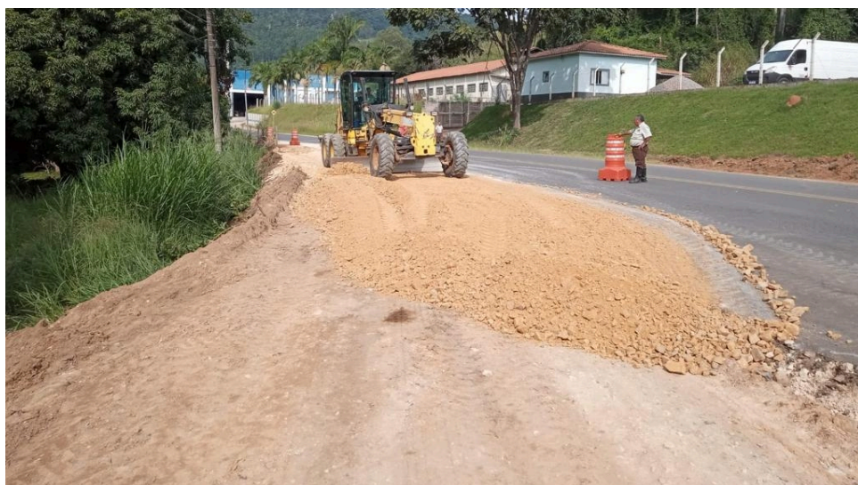
Trevo de acesso ao bairro Brazinho em obra
