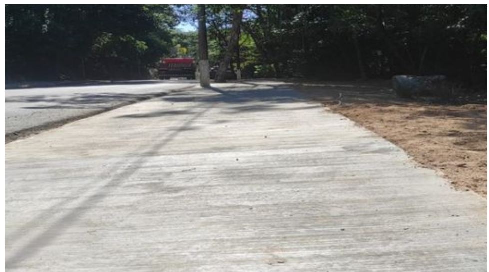
Avenida João Girardelli em obra
