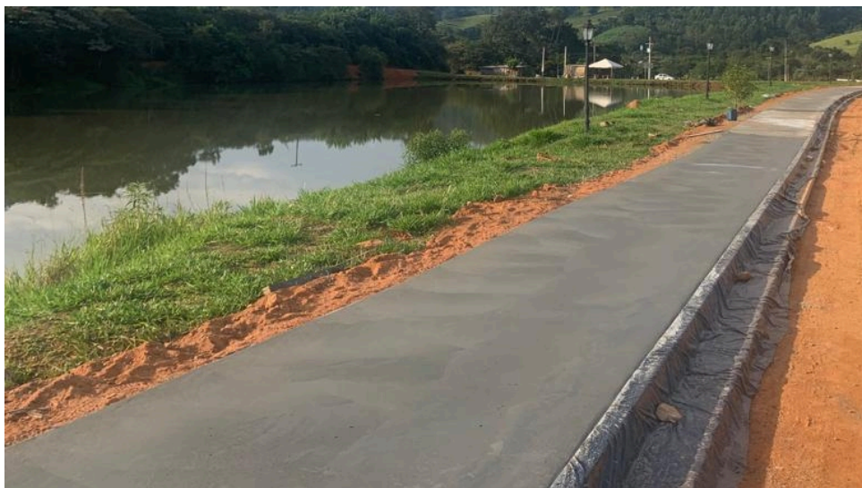
Lago do Falcão em obra
