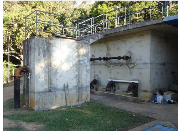
Figura 74. Câmaras de controle de nível da linha 2
