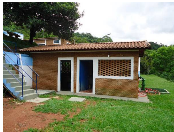
Figura 80. Vista da estação elevatória
