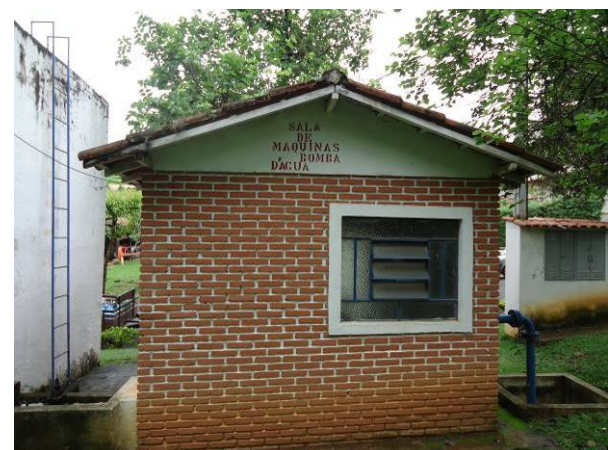
Figura 139. Vista geral da casa de bombas
