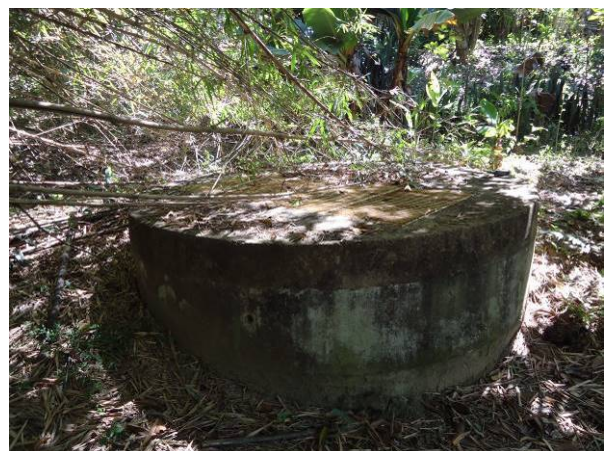
Figura 186. Vista da Estação Elevatória de Esgoto – EEE – 5
