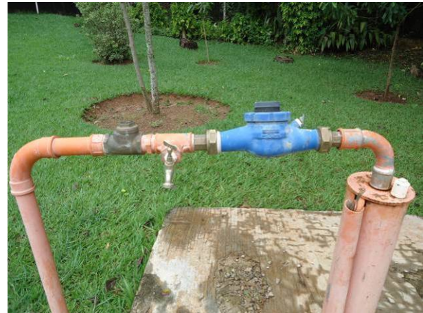
Figura 135. Vista detalhada do poço (P4)
