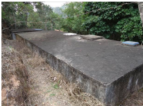
Figura 108. Vista do reservatório R-IV Menino Jesus, câmara 1
