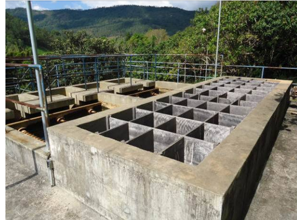
Figura 65. Vista das chicanas da Linha2
