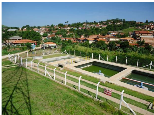
Figura 182. Vista da ETE do loteamento Terras de Monte Alegre
