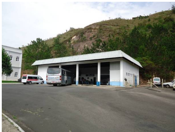
Figura 19. Vista da rodoviária municipal
