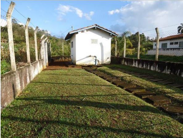
Figura 123. Vista geral do poço
