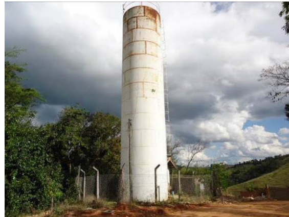
Figura 113. Vista lateral do Reservatório Ponte Preta
