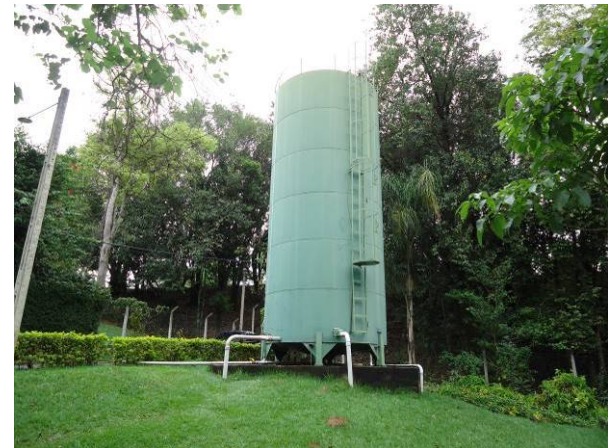
Figura 137. Vista geral do Reservatório R-X-B
