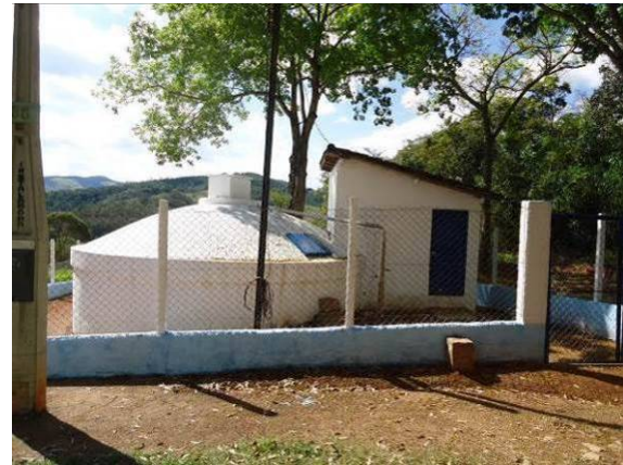
Figura 126. Vista do Reservatório R-VIII apoiado Mostarda
