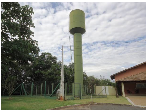
Figura 118. Vista geral do Reservatório Pq. dos Ipês
