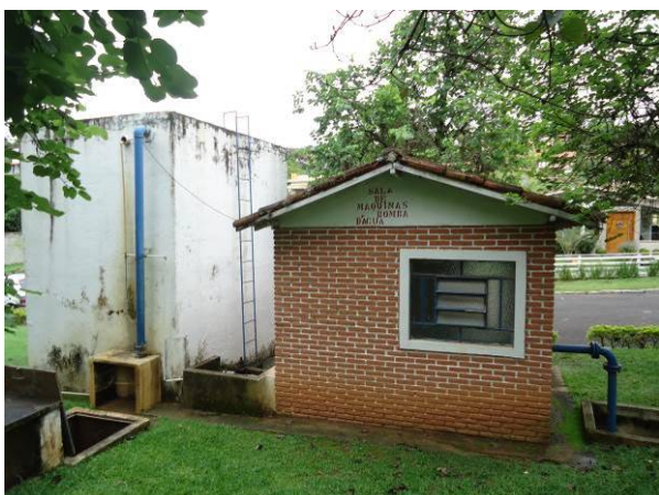
Figura 138. Vista do reservatório (esquerda) e casa de bombas (direita)
