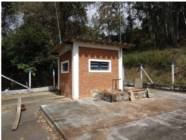
Figura 98. Vista da casa de bombas
