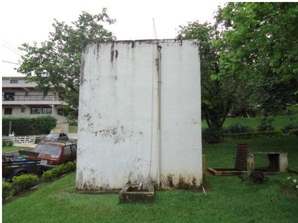
Figura 136. Vista geral do Reservatório R-X-A
