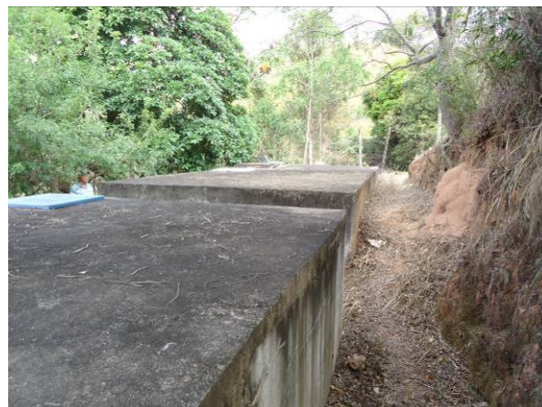
Figura 109. Vista do reservatório R-IV Menino Jesus, câmara 2
