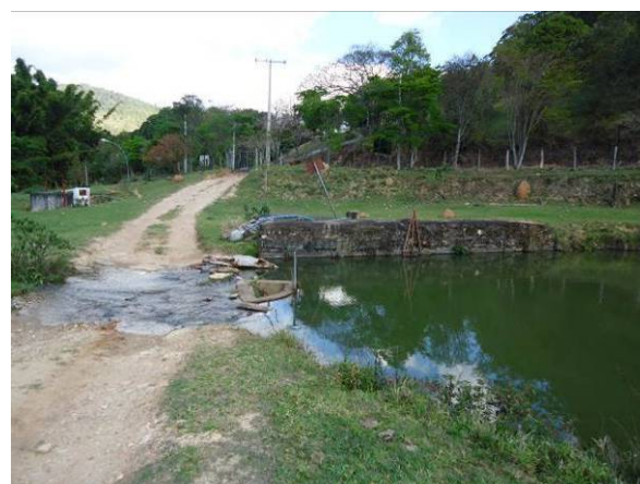
Figura 58. Vista do extravasor da represa de água bruta
