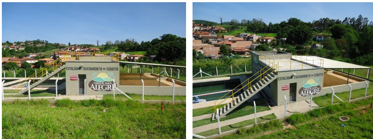
Figura 181. Vista da ETE implantada no loteamento Terras de Monte Alegre
