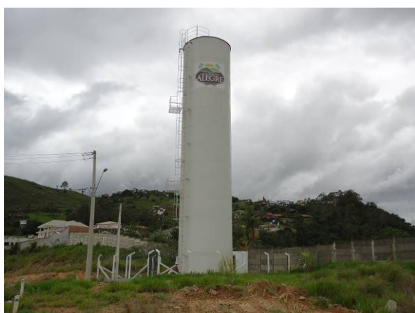
Figura 156. Vista geral do Reservatório R-XI
