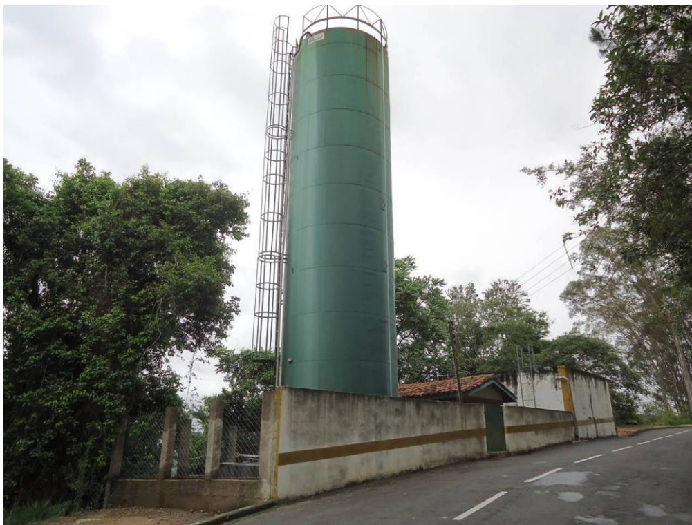
Figura 144. Vista do reservatório metálico (esquerda), da casa de bombas (no centro) e do reservatório de concreto (a direita)
