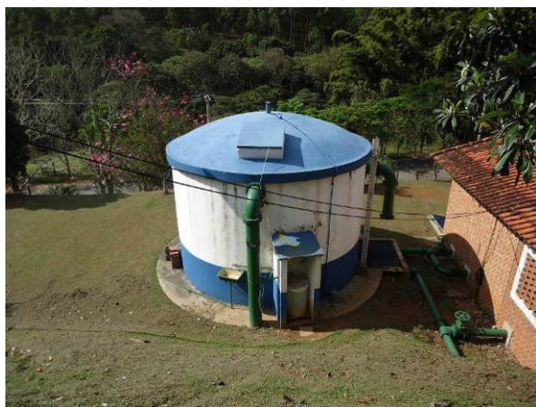
Figura 79. Vista do reservatório R-I
