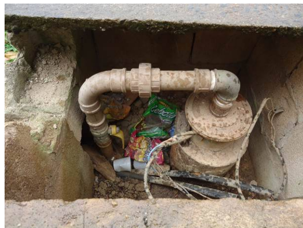
Figura 132. Vista detalhada do poço
