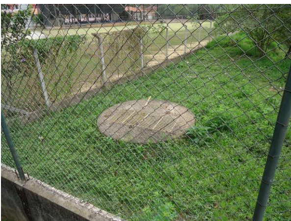
Figura 185. Vista da Estação Elevatória de Esgoto – EEE – 4
