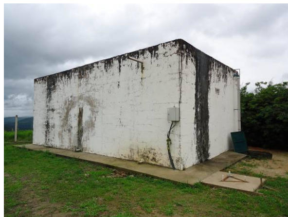
Figura 153. Vista geral do Reservatório R-VIII
