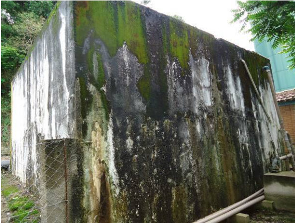
Figura 145. Vista geral do Reservatório R-IX-B
