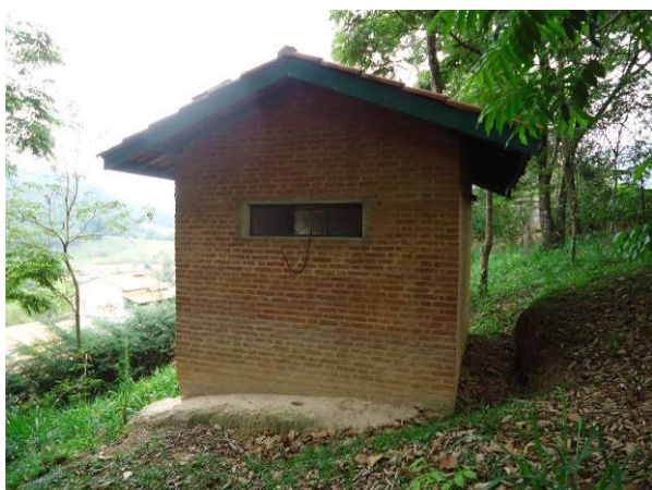
Figura 120. Abrigo com o “booster” do Parque dos Ipês
