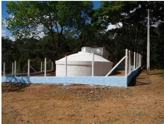
Figura 125. Vista lateral do Reservatório R-VIII apoiado Mostardas
