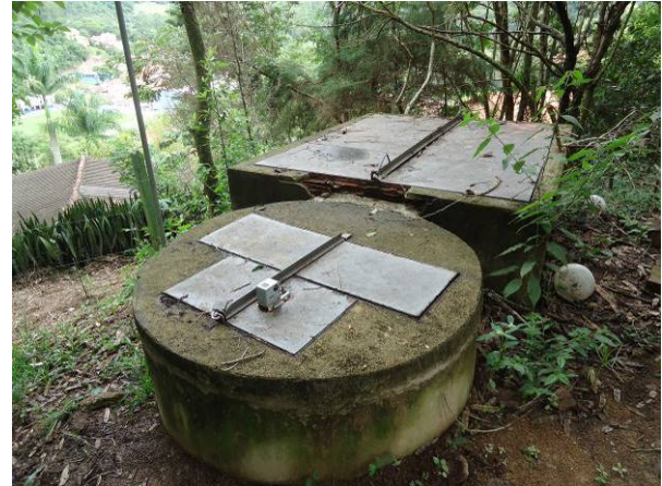
Figura 176. Estação Elevatória de Esgoto (EEE) existente no Parque dos Ipês
