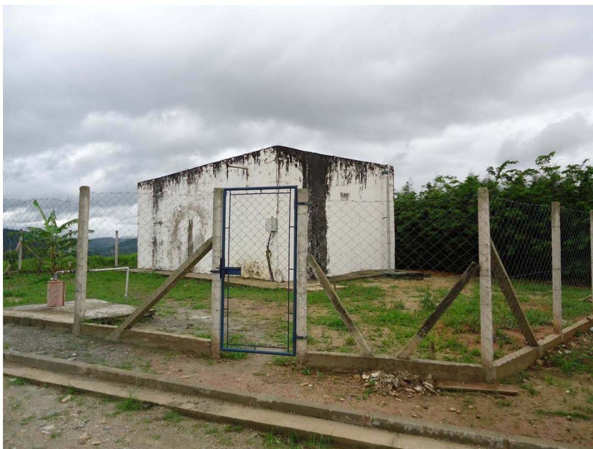
Figura 151. Vista do poço (esquerda) e do reservatório de concreto (direita)
