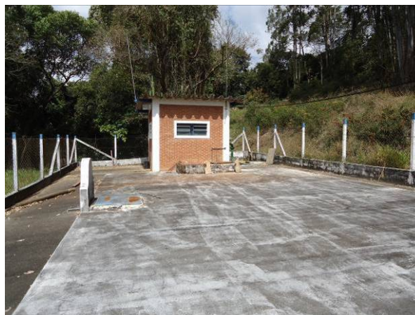
Figura 95. Vista do reservatório R-II, Caixa Baixa e da casa de bombas
