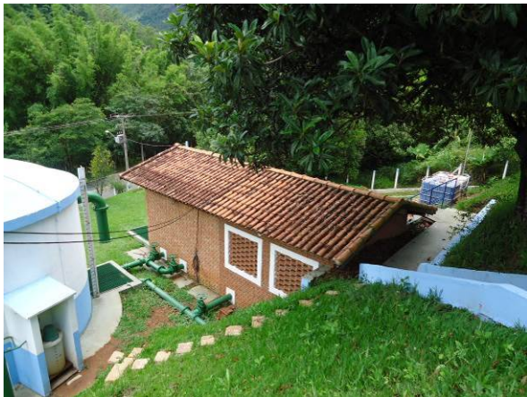
Figura 82. Vista da estação elevatória
