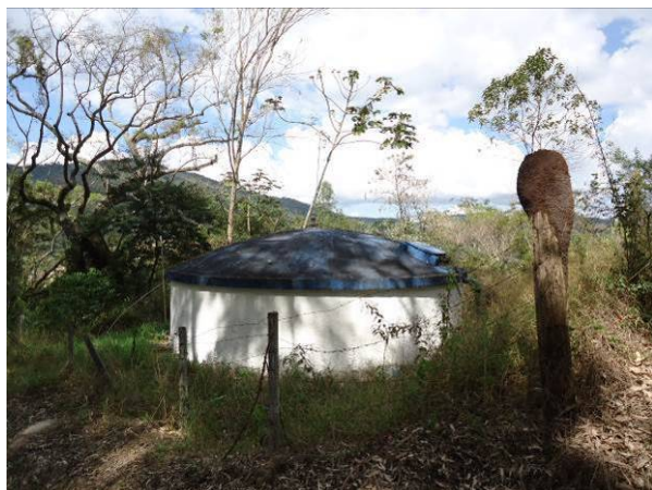
Figura 106. Vista do reservatório Caixa Alta
