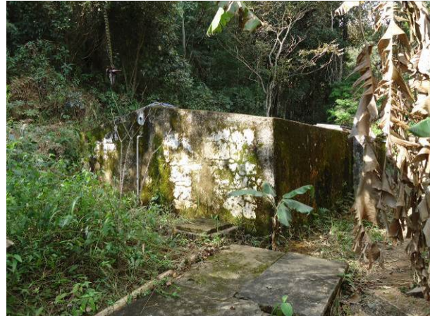
Figura 111. Vista frontal do Reservatório Girardelli
