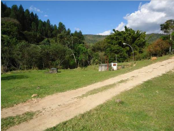
Figura 59. Vista da tomada de água bruta
