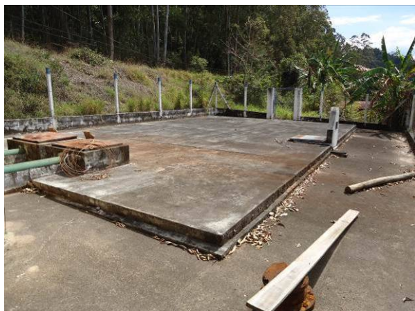
Figura 94. Vista do reservatório R-II, Caixa Baixa
