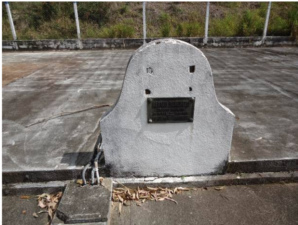
Figura 96. Vista da Placa de Identificação do Reservatório
