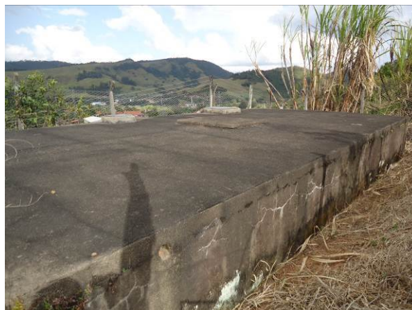
Figura 115. Vista geral do Reservatório Ponte Preta
