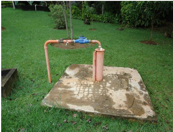
Figura 134. Vista geral do poço (P4)
