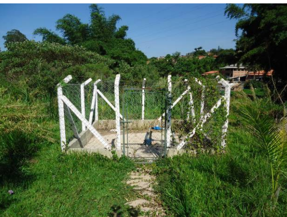
Figura 162. Vista geral do poço P6
