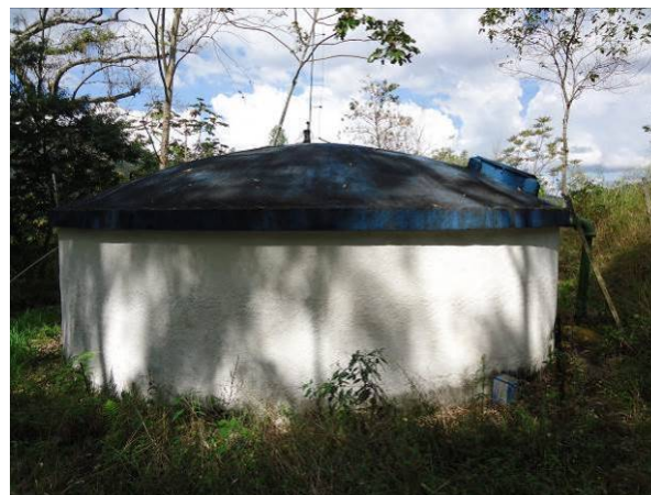
Figura 107. Vista do reservatório Caixa Alta
