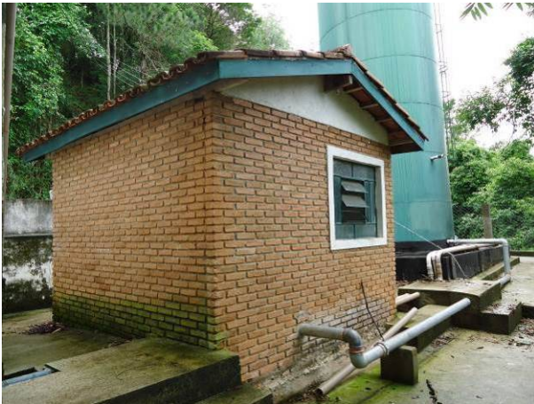
Figura 147. Vista geral da casa de bombas
