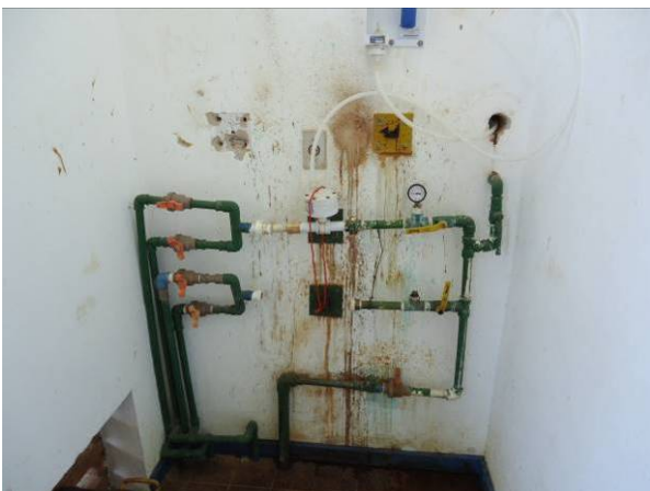
Figura 75. Vista do sistema de aplicação do cloro gás.
