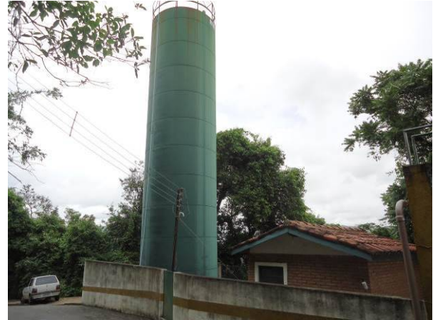
Figura 146. Vista geral do Reservatório R-IX-A
