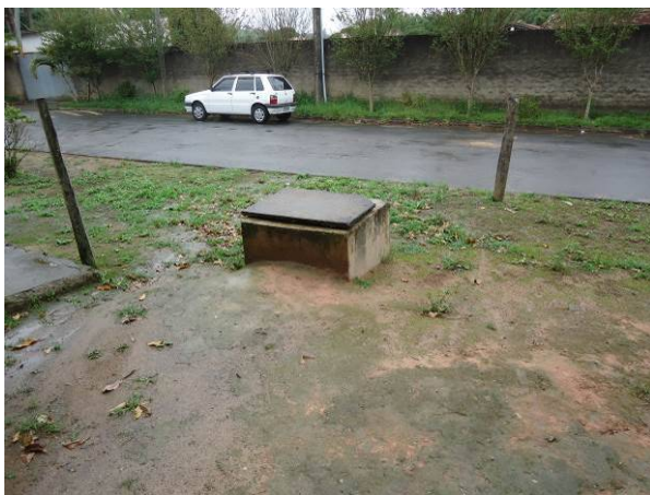
Figura 129. Vista da proximidade do poço em relação a rua
