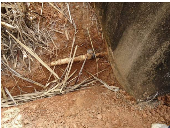
Figura 116. Saída do reservatório
