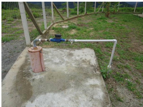
Figura 152. Vista geral do poço
