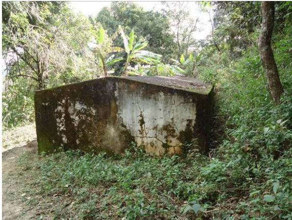
Figura 110. Vista posterior do Reservatório Girardelli
