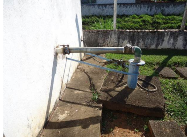
Figura 124. Vista do poço
