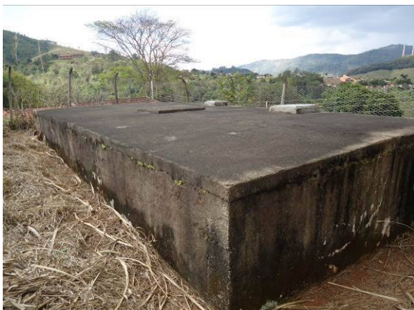
Figura 114. Vista geral do Reservatório Ponte Preta
