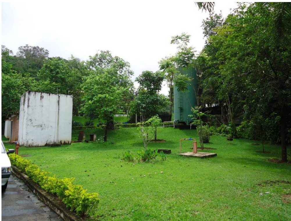
Figura 133. Vista do reservatório de concreto (R-X-B), reservatório metálico (R-X-B) e poço (P4)
