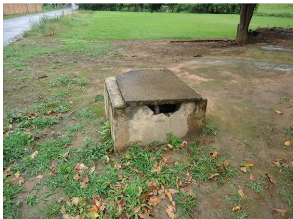
Figura 131. Vista geral do poço
