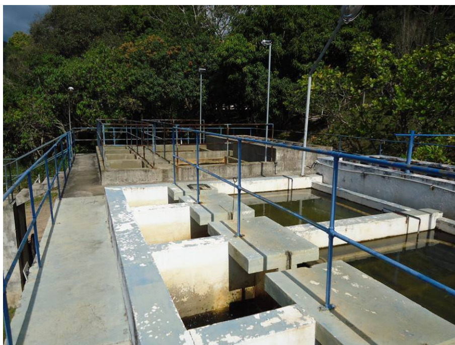
Figura 72. Vista da parte superior dos filtros
